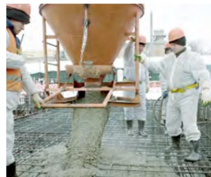
инженерные и электрические коммуникации прокладываются до заливки бетона.
